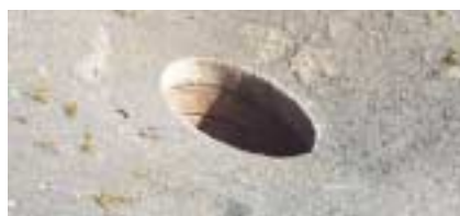
Orifices des puits.
