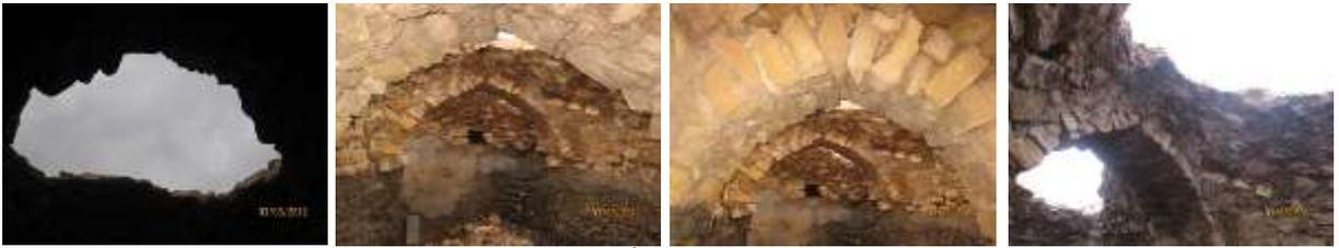
دوم متر است که طاق آن با مصالح سنگ و ملاط گچ و آهک به شکل جناقی می‌باشد.
