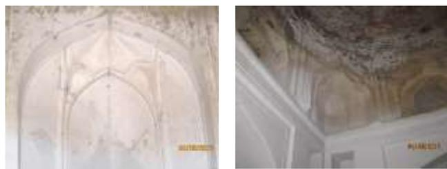
گنبد بنا یک پوششی و از داخل با روش جناغی اجرا شده است. سطح زیر گنبد را اندودی از گچ پوشانیده لکن سبب نفوذ رطوبت و صدمه زیادی دیده است و بایستی مجددا تراشیده و
