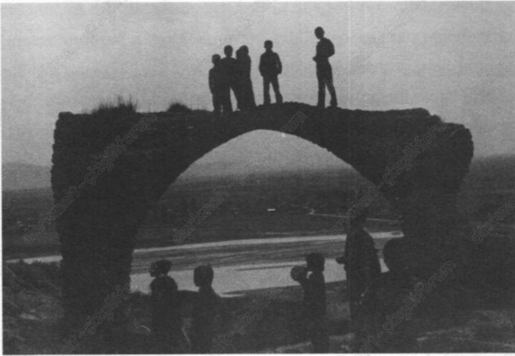
Anavarza'nın "Kale kapısı"
